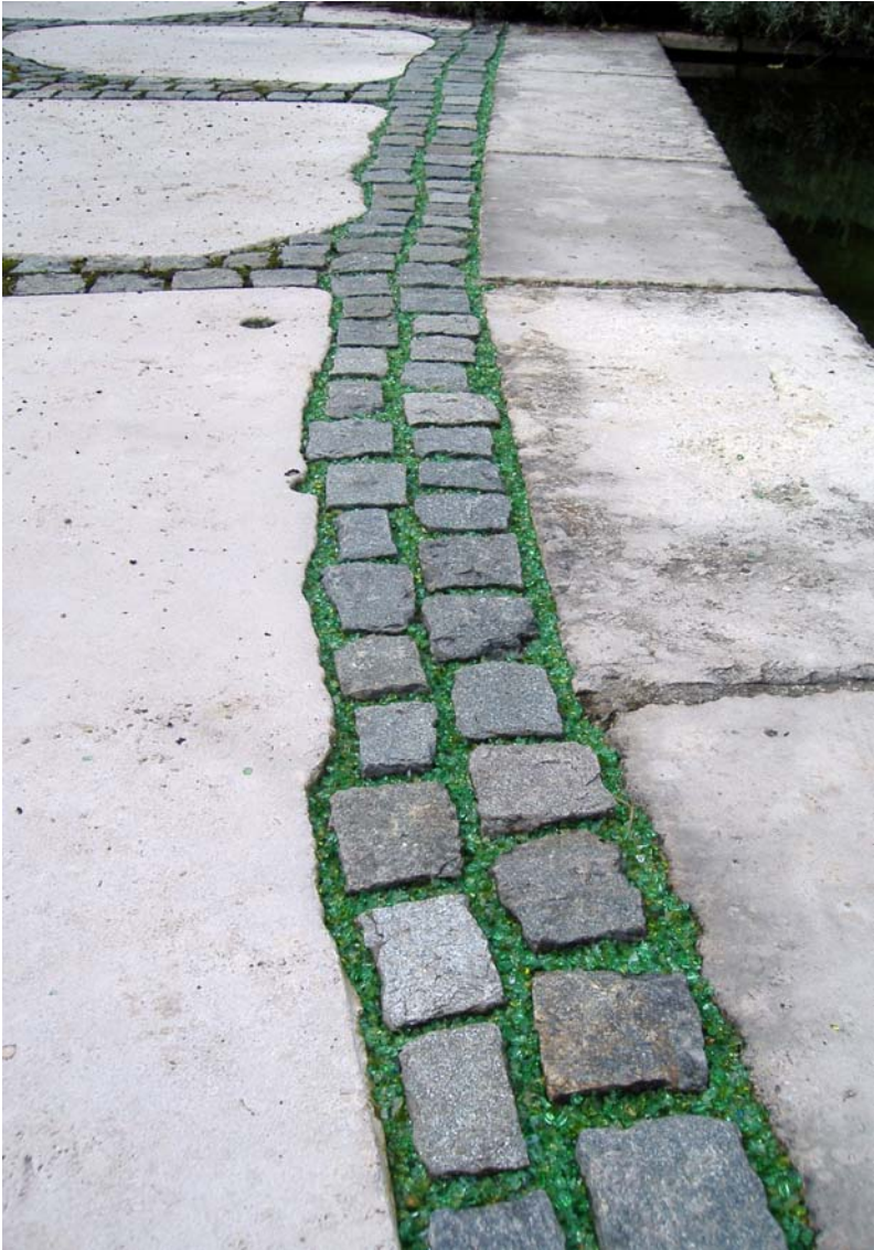
Abb. 8: Pflasterfugenfüllung mit grünem Glassplitt
